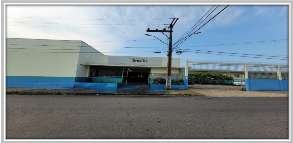
Foto 1 - Vista frontal da escola Brasília
