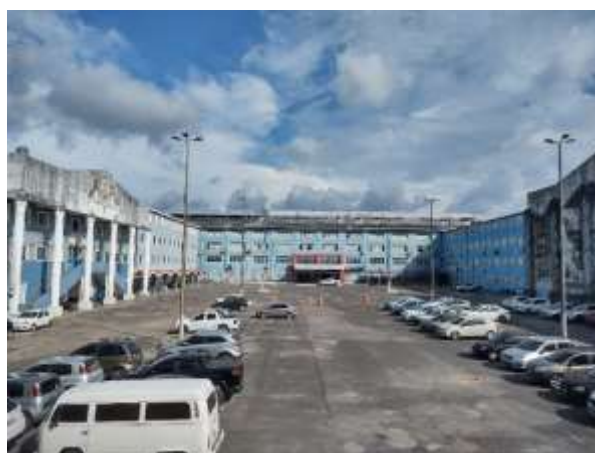
Figura 6: Complexo da Universidade Nilton Lins onde está localizada a Escola Estadual Tenente Coronel Cândido José Mariano CMPM -V. Foto: Autor (2023).
