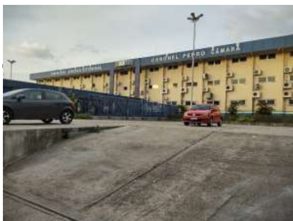
Figura 10: Estacionamento interno da Escola Estadual Coronel Pedro Câmara – CMPM VIII. Foto: Autor, (2023).
