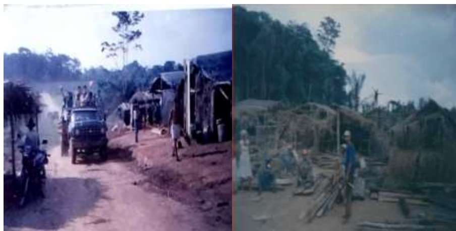
Figuras 2 e 3 – O acampamento Che Guevara em construção
